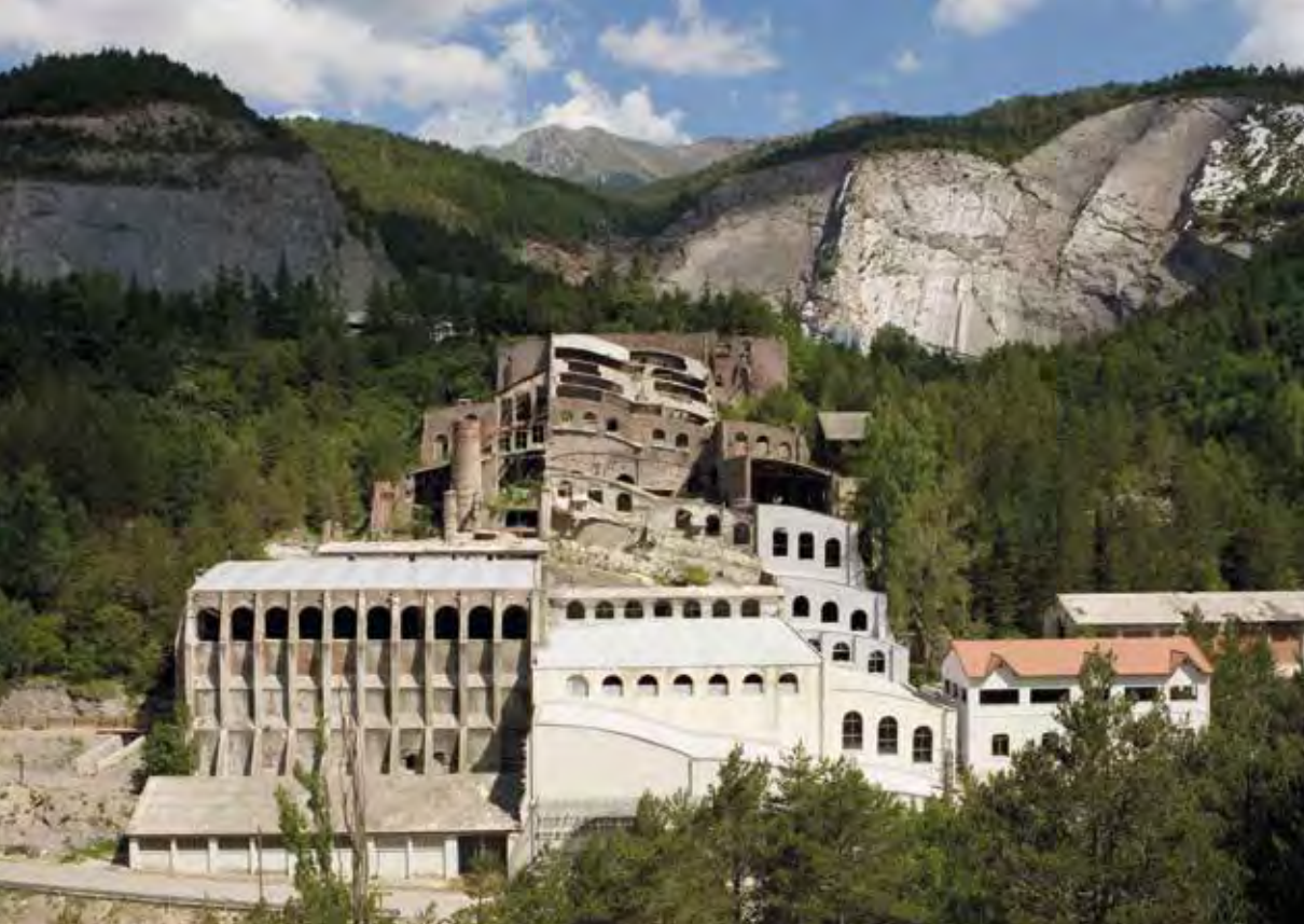
CASTELLAR DE N'HUG. FÀBRICA DE CIMENT ASLAND
